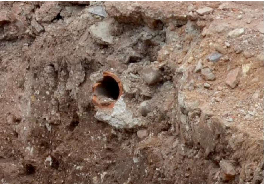
Figura 9. Canal de conducción de aguas en una de las piletas o balsas de evaporación al sol de una salitrería en Alcázar. La conducción de las lejías entre varias piletas permitía eliminar las impurezas. Junio 2015. Imagen del autor.
