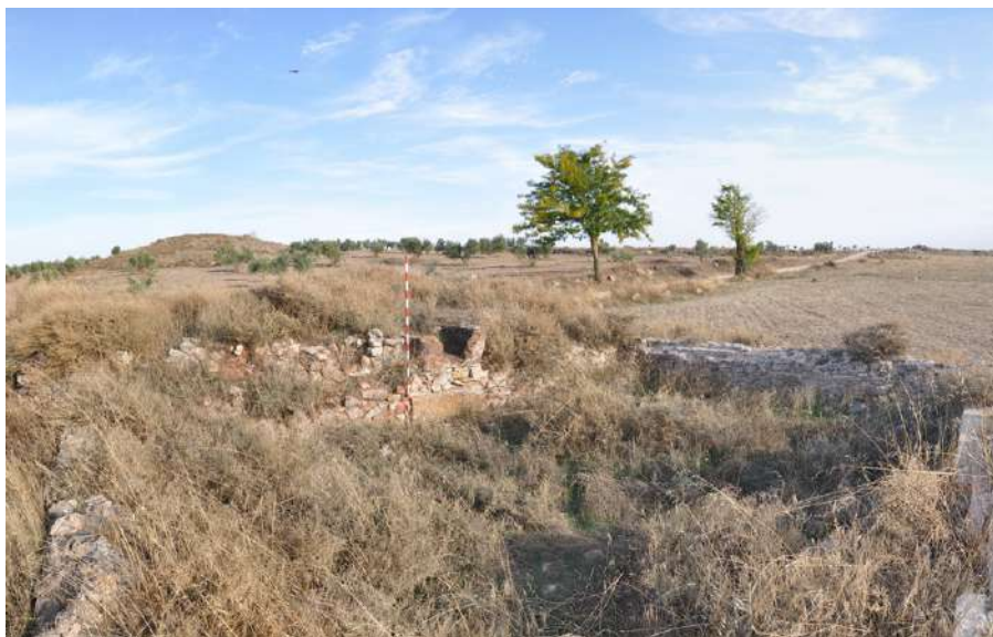
Figura 17. Interesante estructura hidráulica conservada en Piédrola.
