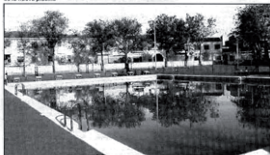
El nuevo vaso está instalado junto al resto de piscinas municipales, la de 50 metros y la de niños además de la cubierta. La inversión ha ascendido a 25 millones de ptas. de los que 10 ha puesto el Ayuntamiento y 15 la Junta de Comunidades
