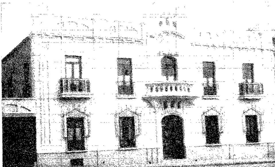
Fachada de la casa de D. Oliverio, aligerada de sus ornamentos, donde está instalado el Colegio actualmente.
